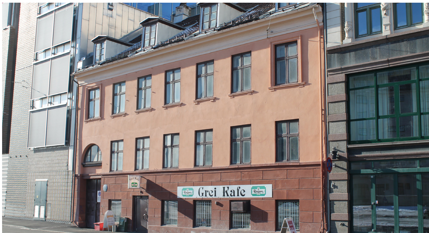
Skippergata 3 under rehabilitering. Bygget er foreslått fredet. Foto: Storebrands arkiv
